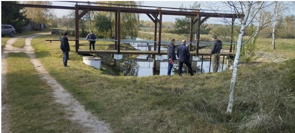
Огляд аванкамери та механізму подачі насоса в аванкамеру насосної станції
