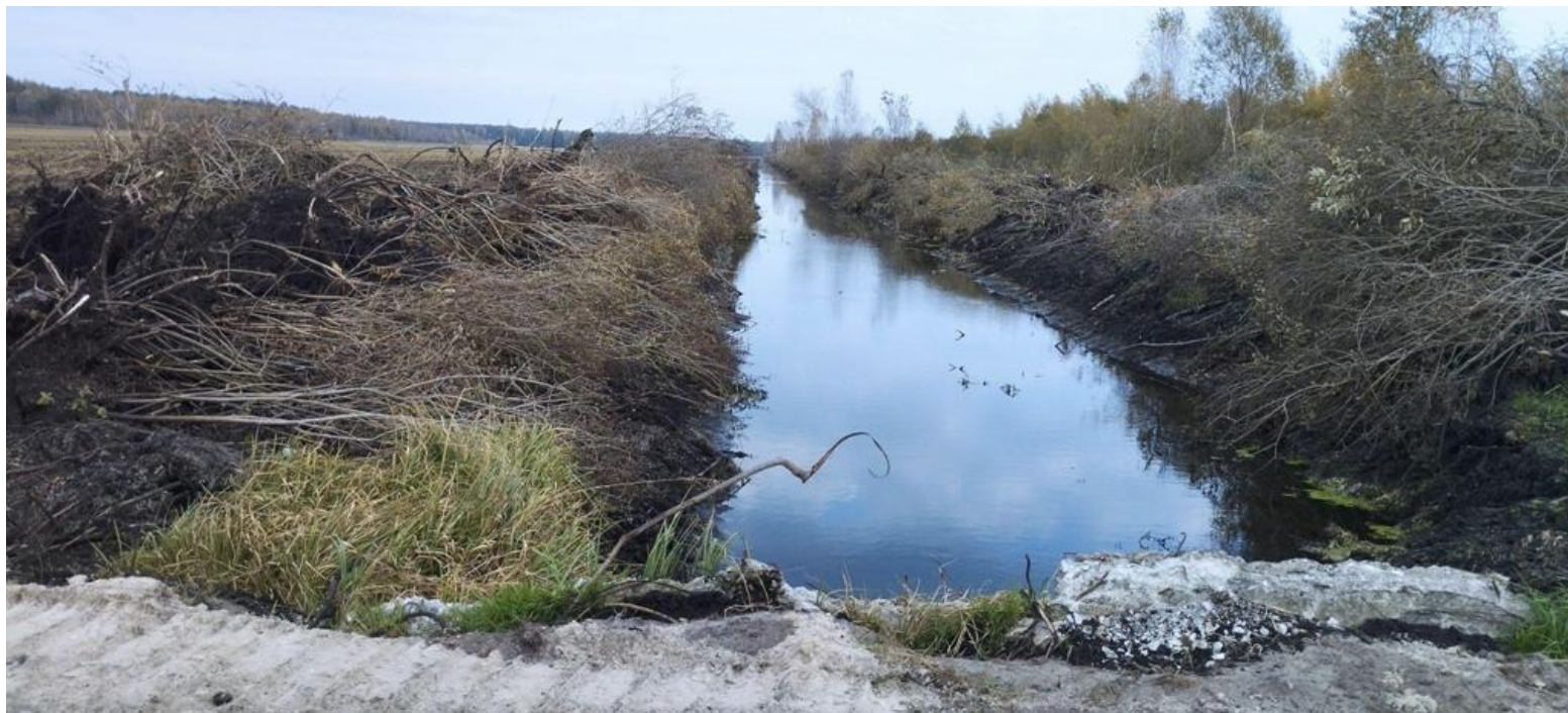
Очищенный канал К-11-2 ПК0+20, ТП-80
