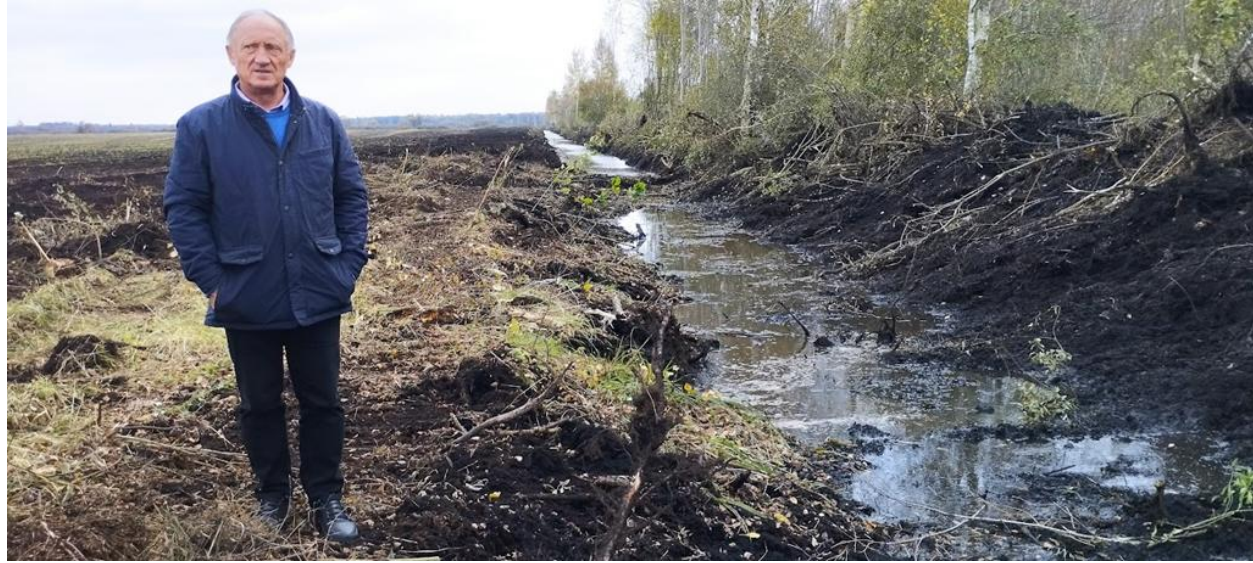
Очищення каналу К-6 силами землевласників
